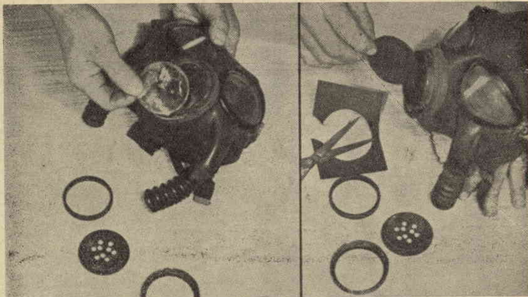
2 - Togliere il diaframma di plastica, svitando il suo ritegno e rimuovendo disco di metallo perforato ed anello. Tagliare un diaframma di caucciù che si adatti perfettamente all'apertura, in modo da avere una maggior sicurezza ed una più certa tenuta d'acqua.
